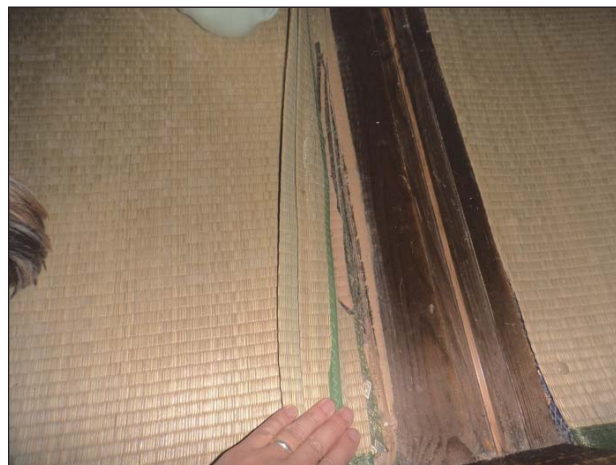
床仕上・畳に損傷が見られる。
