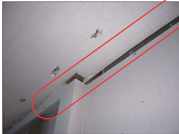
【天井】 天井板のずれが見られる。
