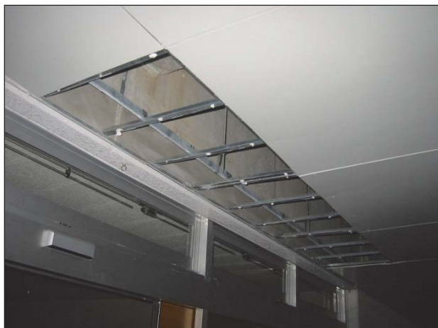
【天井】 天井板が脱落している。
