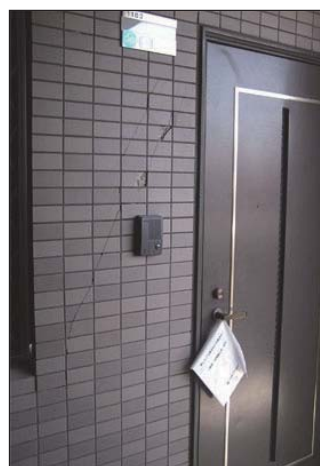
【雑壁】 各所にひび割れ(幅約0.2mm～1mm)やはがれが生じている。
