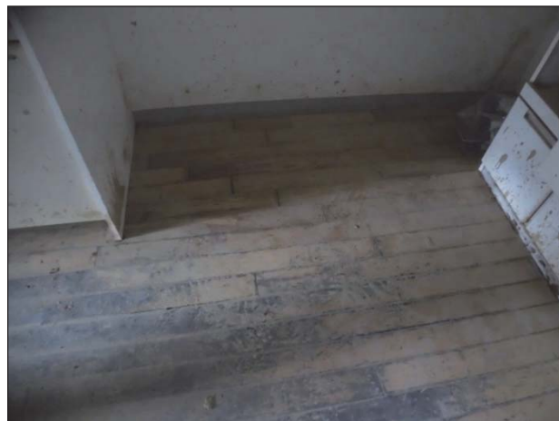
浸水により床材の汚損が見られる。
