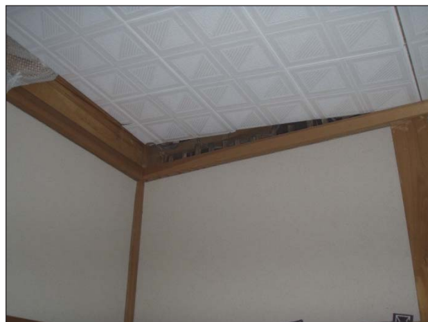
【天井】 天井板の浮きが生じている。
