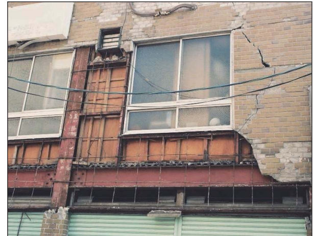
全面にわたる大きな亀裂が見られ、面外への大きなはらみ出し、大きな剥落が見られる。
