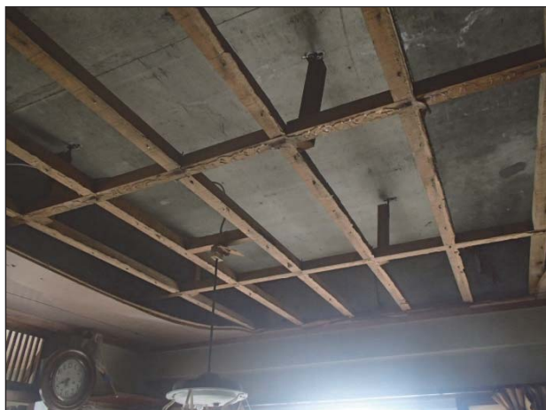
【天井】 天井板が脱落している。
