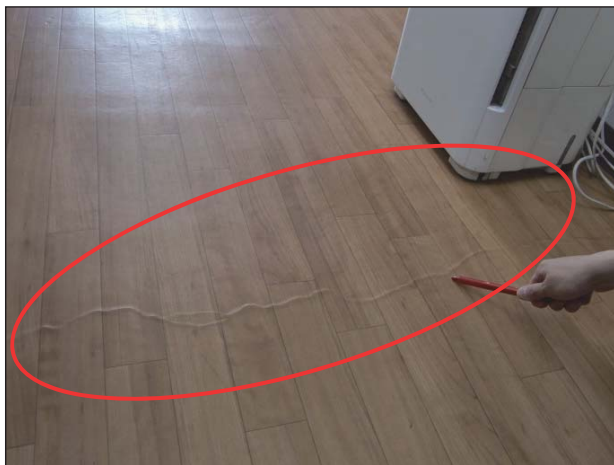
床仕上・畳に損傷が生じている。
