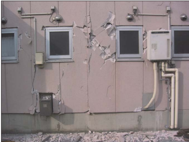
大きなひび割れ又は仕上の剥離が見られる。また、仕上材の目地の破壊が見られる。
