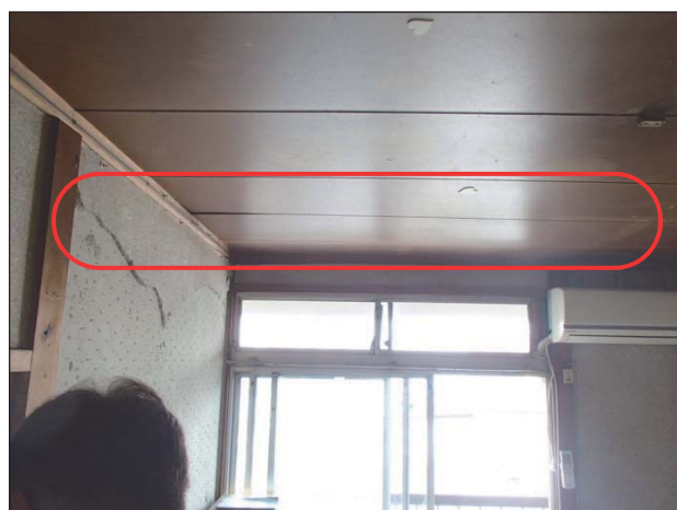
【天井】 天井板に隙間が生じている。
