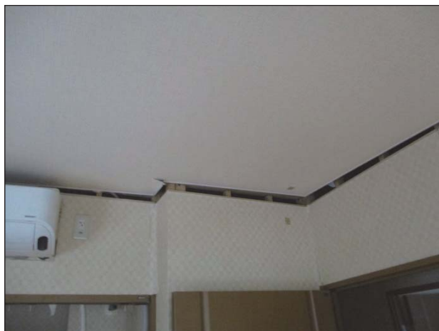
【天井】 天井板のずれが見られる。
