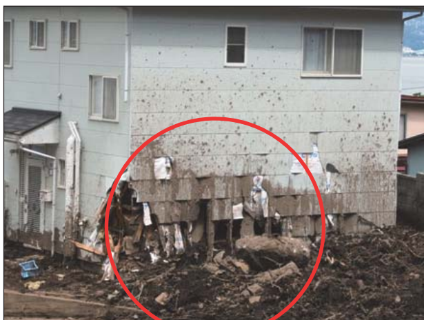
【枠組壁工法】 枠材に折損が生じており、合板の脱落、破損が生じている。
