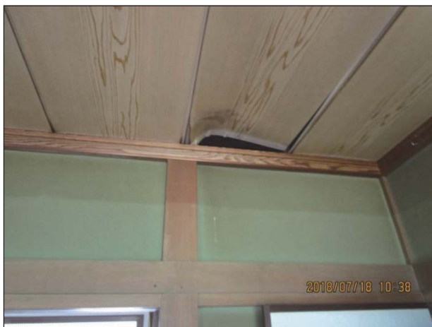
天井板の浮きが生じている。
