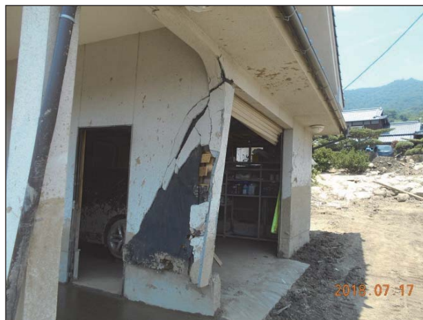
【枠組壁工法】 枠材に折損が生じており、合板の脱落、破損が生じている。
