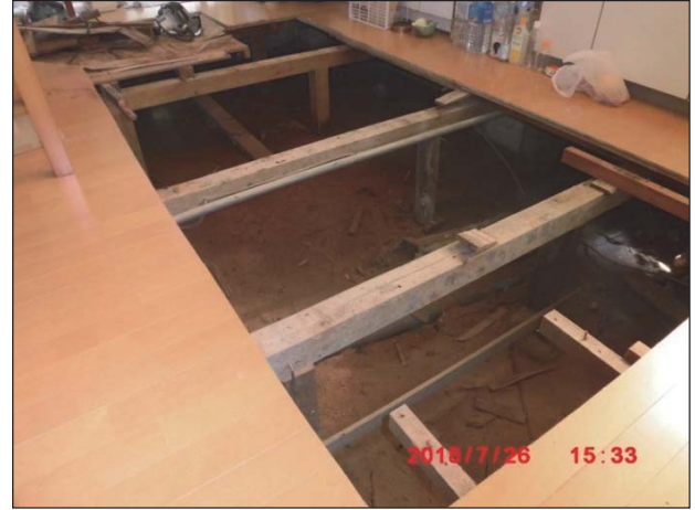
20072 床下に堆積した汚泥を除去するため、床の一部(床板等)の取り外しが必要である。(基礎の構造が布基礎又はべた基礎の住家に限る)
