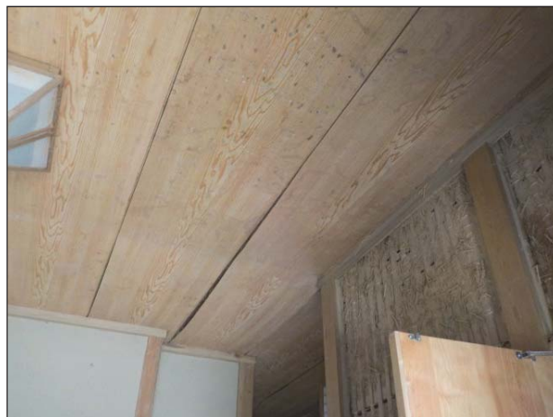
天井板に隙間が生じている。
