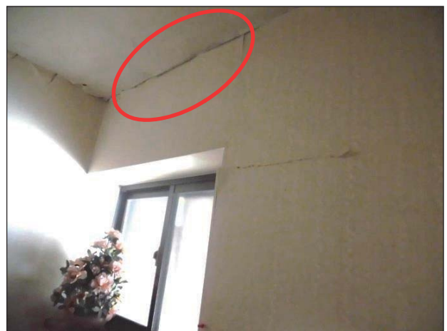
天井板に隙間が生じている。
