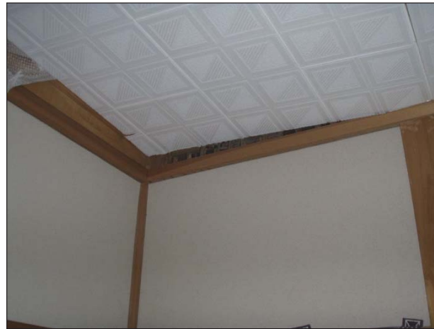
天井板の浮きが生じている。
