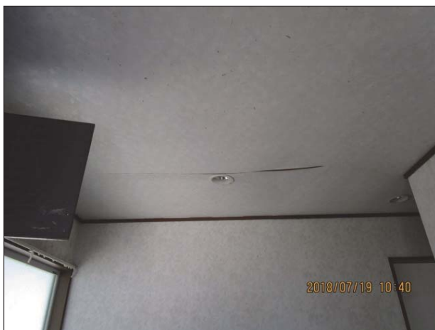
天井板に隙間が生じている。
