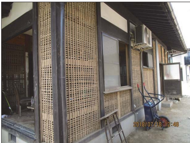
【仕上面】 塗り壁では壁面の大部分で仕上材が脱落している。
