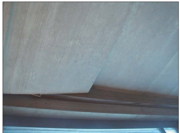
天井板の浮きが生じている。
