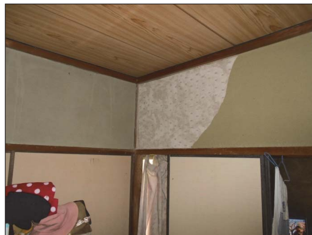
浸水により塗土の半分程度が剥落している。
