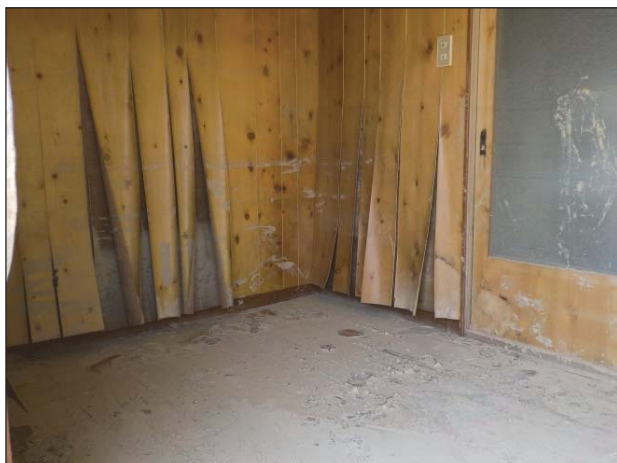
(浸水により仕上材の剥離等が見られる。)
