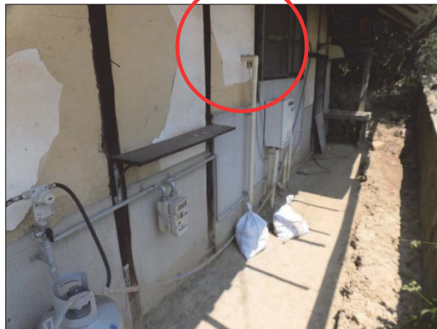
浸水により塗土の半分が剥落している。
