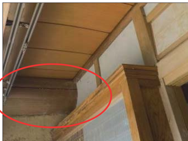
【在来工法】 柱、梁に割れが見られる。
