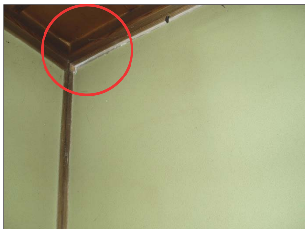
内壁周辺部に隙間が生じている。
