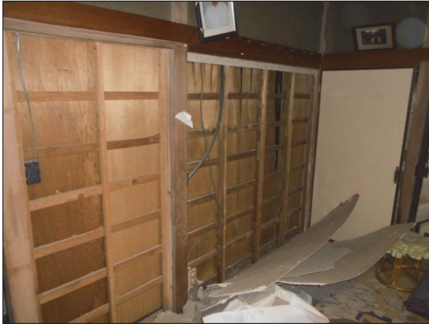
内壁合板に剥離、脱落が見られる。
