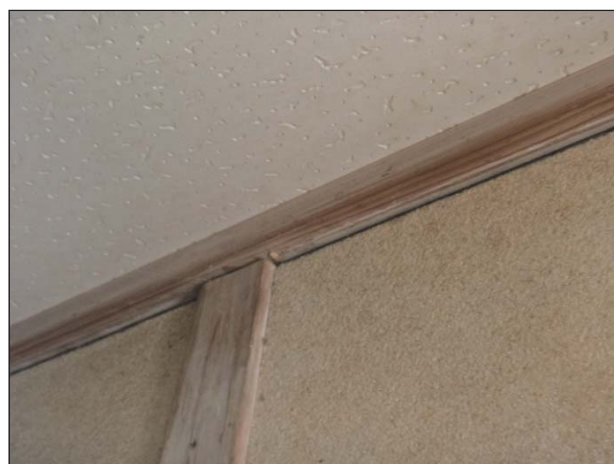
内壁周辺部に隙間が生じている。
