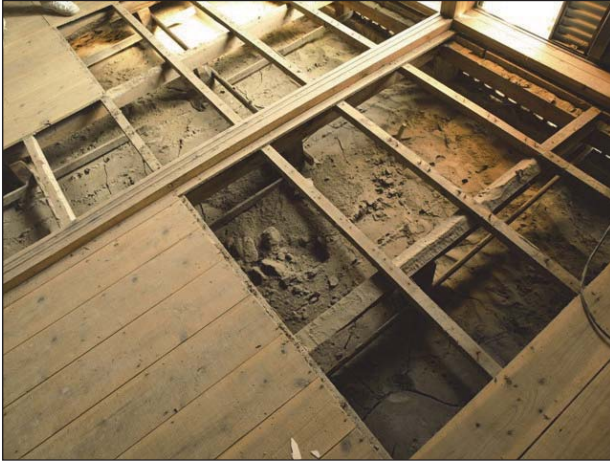
20026 床下に堆積した汚泥を除去するため、床の一部(床板等)の取り外しが必要である。(基礎の構造が布基礎又はべた基礎の住家に限る)
