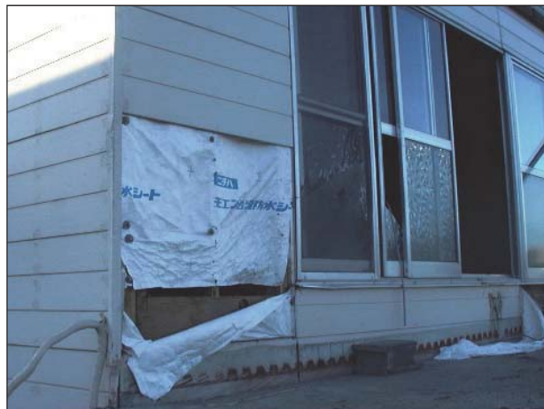
【仕上面】 ボード仕上の壁では大部分で釘の浮き上がりが見られ、中には脱落したも見られる。
