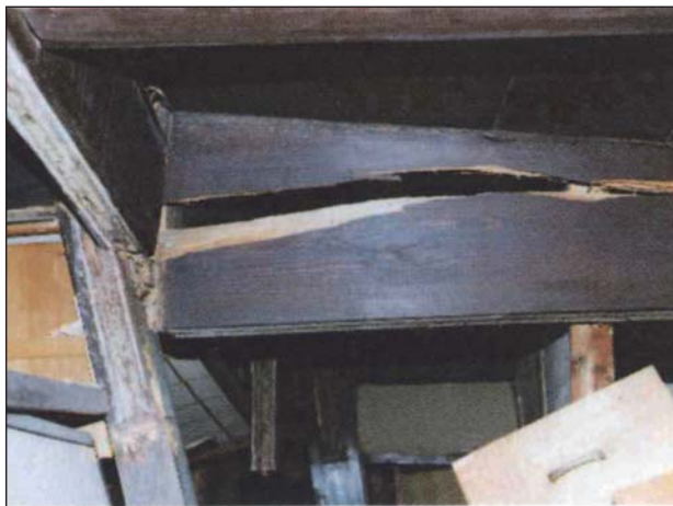
【在来工法】 柱、梁に折損が見られる。
