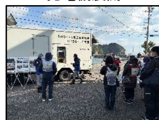
▼電力会社による発電機展開
