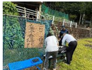
▼避難場所を示す看板を設置
