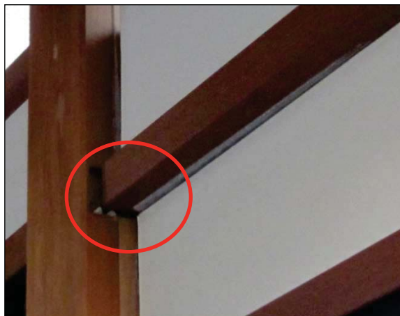
柱と梁の仕口にずれが生じている。
