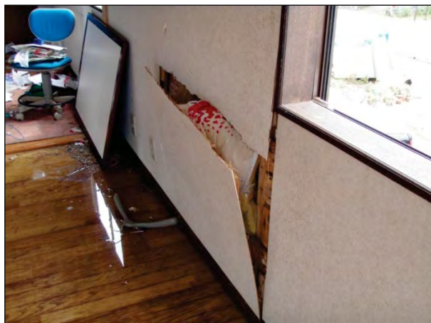
内壁合板に剥離、脱落が見られる。
