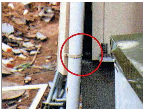
アンカーボルトの伸びが見られる。
