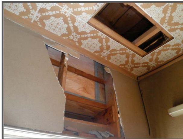
内壁合板に剥離、脱落が見られる
