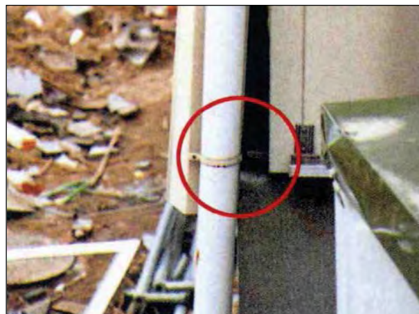
アンカーボルトの伸びが見られる。
