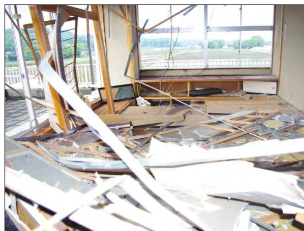
【アルミサッシ、木製サッシ】 枠ごと外れて破壊されている。
