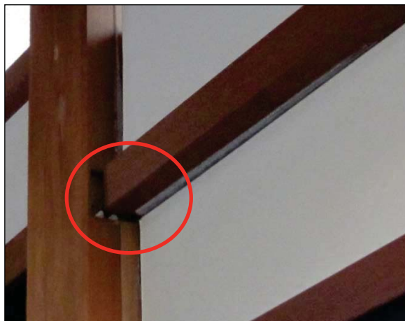
柱と梁の仕口にずれが生じている。
