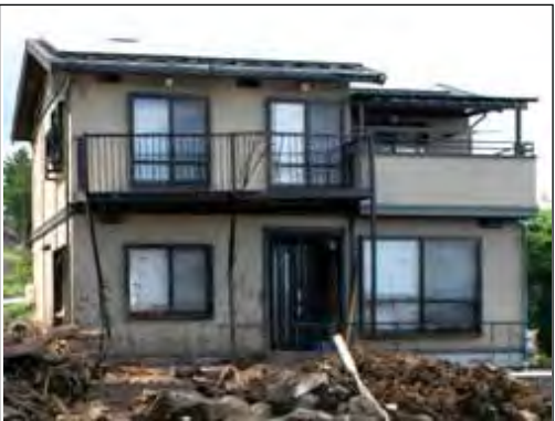
(ベランダ：外力等により変形している。)
