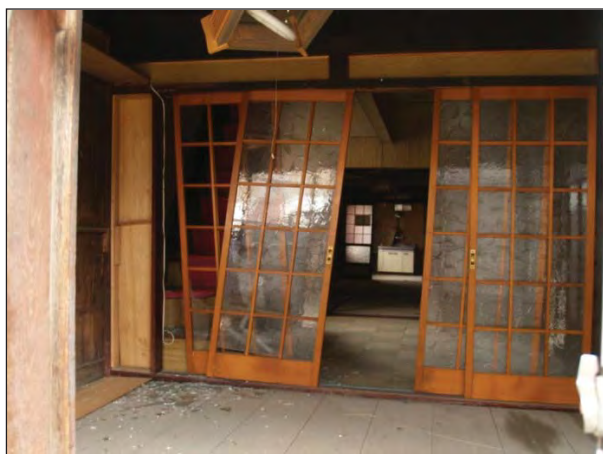
【襖、障子】 かまち(戸・窓・障子など建具の周囲の枠)の損傷が著しく、交換が必要である。
