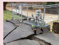
水道の復旧 (被災した浄水場)
