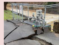
水道の復旧 (被災した浄水場)
