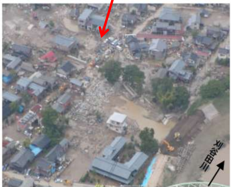
【破堤により流失した家屋 (新潟県中之島町)】
