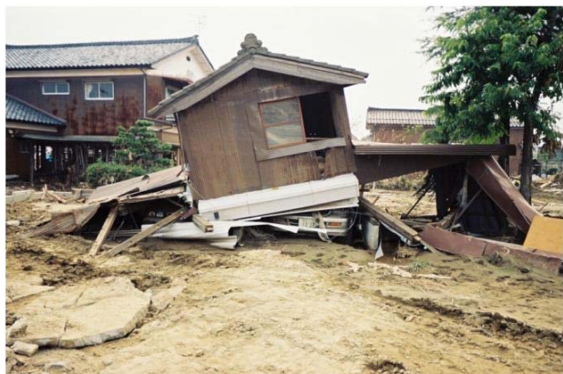
1階が崩れた家
