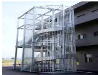
避難階段の設置
