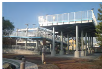
津波避難タワー
