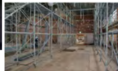
安全性向上のための改修
