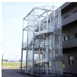
避難階段の設置
