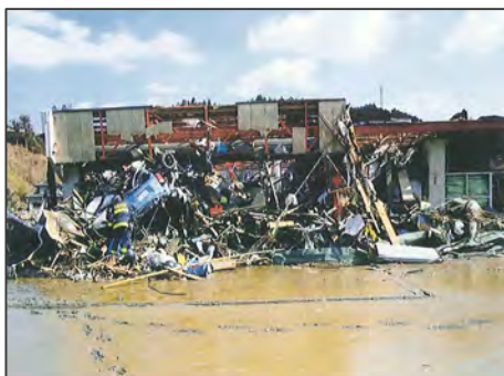
被災状況（津波）
