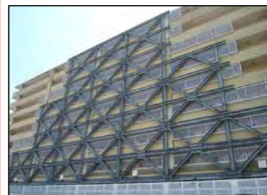
耐震補強工事
