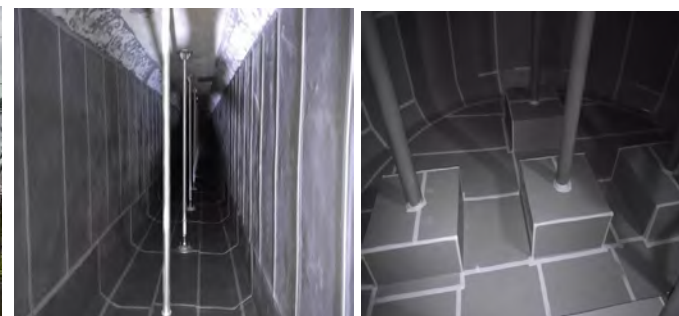
【防火水槽内部写真】支柱等を設置し、水槽強度の強化（長寿命化）
