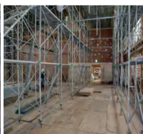
安全性向上のための改修
