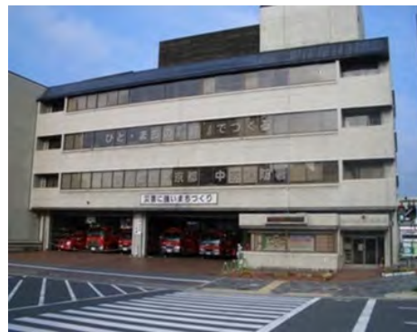
消防署 (京都市消防局)
