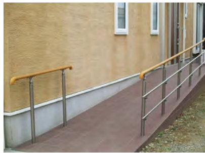
スロープの設置
