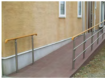
スロープの設置
