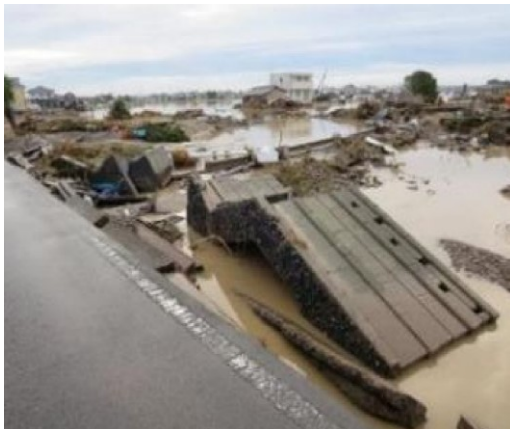
家屋等の流出の様子
