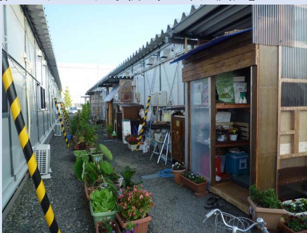
玄関の袖壁を利用した収納スペースの増設
