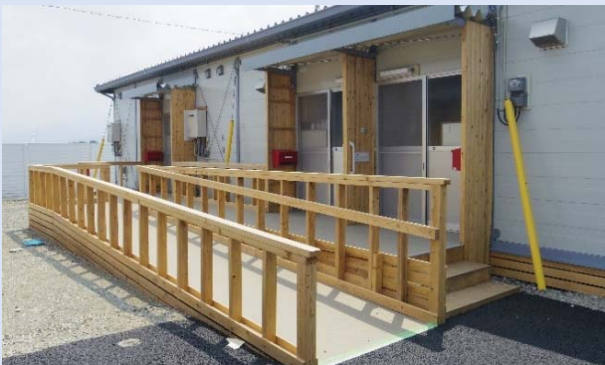
共用スロープ設置の例
