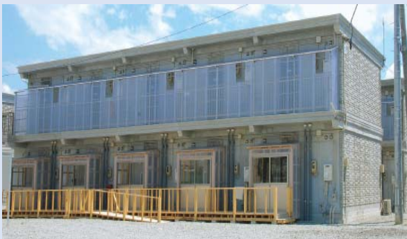
WPC工法(壁式プレキャスト鉄筋コンクリート工法)による2階建て (プレ協住宅部会、福島県郡山市)
