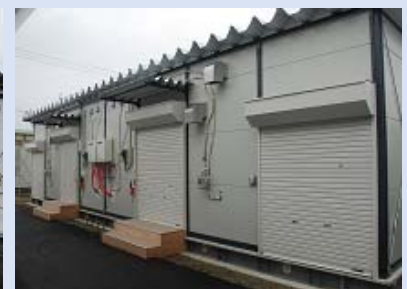
外壁材(パネル)を活用した 手動雨戸設置の例
