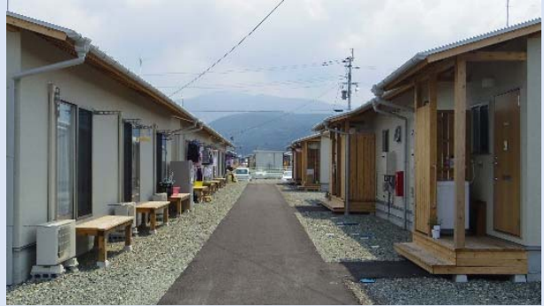
出入口のステップ設置の例
