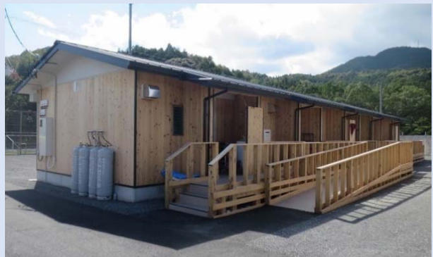
共用スロープ設置の例
