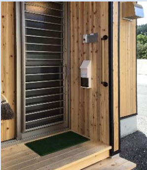
玄関(屋外)手すり設置の例
