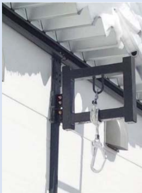
雪下ろしのための 屋根昇降用ハシゴ 固定金物設置の例
