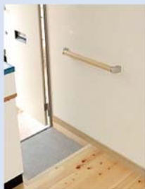
手すり設置の例
