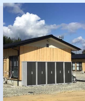
屋外収納の例 (出典:熊本地震 木造応急仮設住宅建設の取り組み((一社)木を活かす建築推進協議会))
