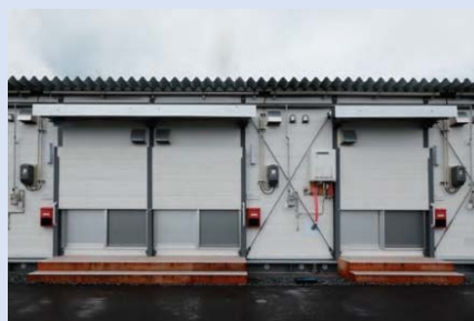
外壁材(パネル)を活用した 手動雨戸設置の例
