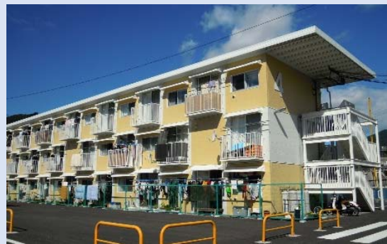
コンテナを活用した3階建ての例 (事例2:宮城県女川町の例)
