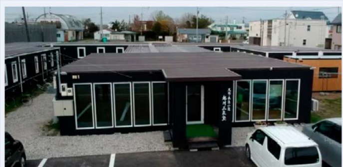
北海道むかわ町学生用仮設住宅 (36 名用) モバイルハウスを供与 (写真提供：北海道むかわ町)
