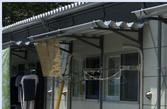
庇の下に設けられた物干し金物の例
