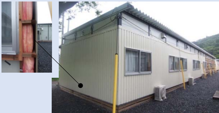
外断熱による断熱材設置の例(追加工事)
