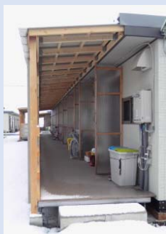
屋根付きの外廊下設置の例※
