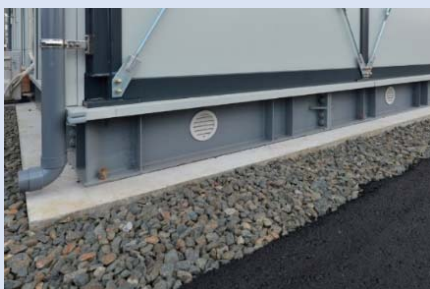
鋼製基礎設置の例
