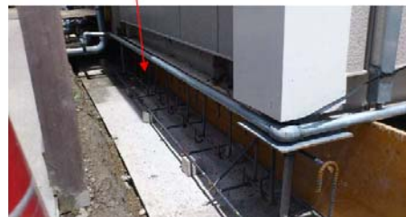
窓の二重サッシ化
