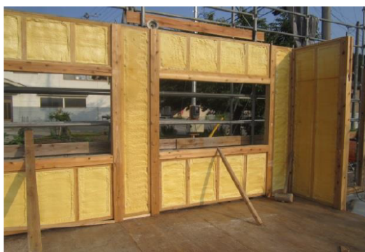
再利用した壁パネル
