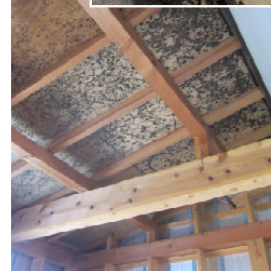
浸水水害によるカビの発生 (浸水していない天井でカビが発生)
