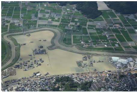
被災時の大町町全景
