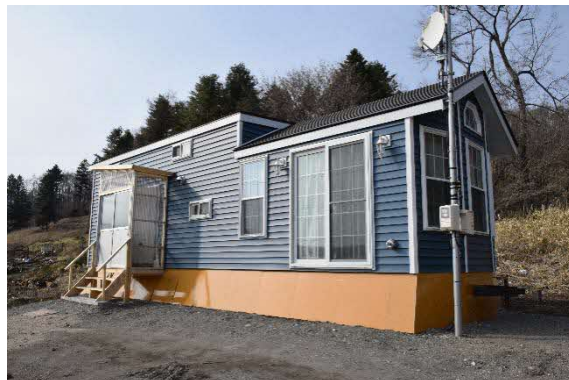
トレーラーハウス（宇隆地区）
