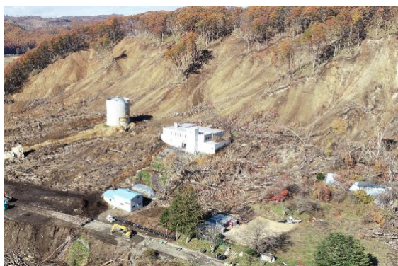
浄水場（富里地区）の被害状況
