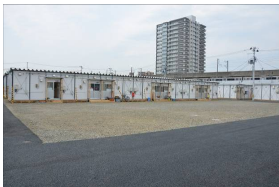
応急仮設住宅の様子①
