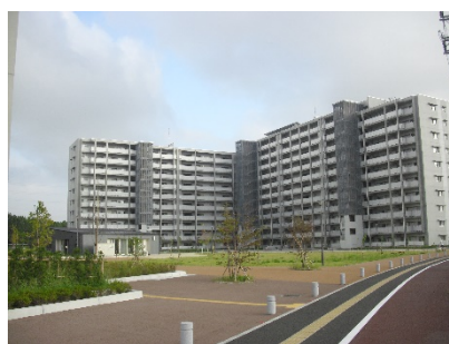
災害公営住宅（荒井東地区）
