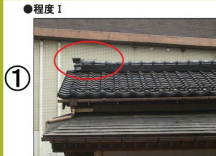
棟瓦(がんぶり瓦、のし瓦)の一部がずれ、破損が生じている。 (棟瓦の損傷が認められる場合は棟瓦を挟む両屋根面で損傷を算定する。)
