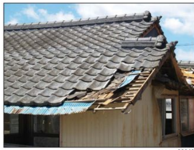
(下地材の損傷が見られる。)
