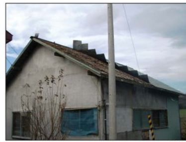
金属版葺材の半分程度がはがれている。
