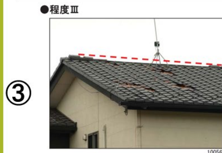
棟瓦が全面的にずれ、破損あるいは落下している。
