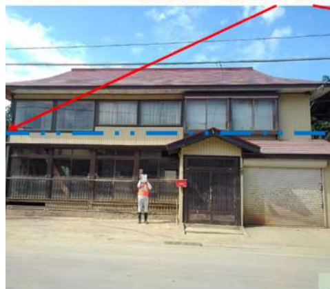
蔵岡地区 浸水深 床上3.30m 大規模半壊
