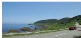
(室ヶ崎(珠洲市))
