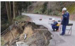
危険箇所での被災状況調査
