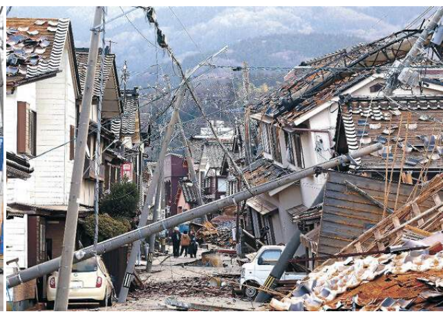
輪島市等の家屋倒壊
