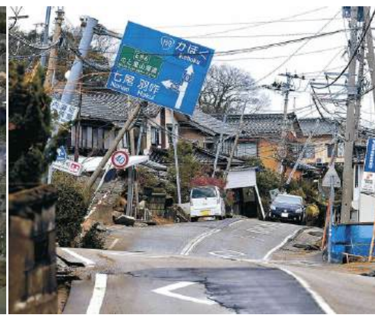
内灘町の液状化被災
