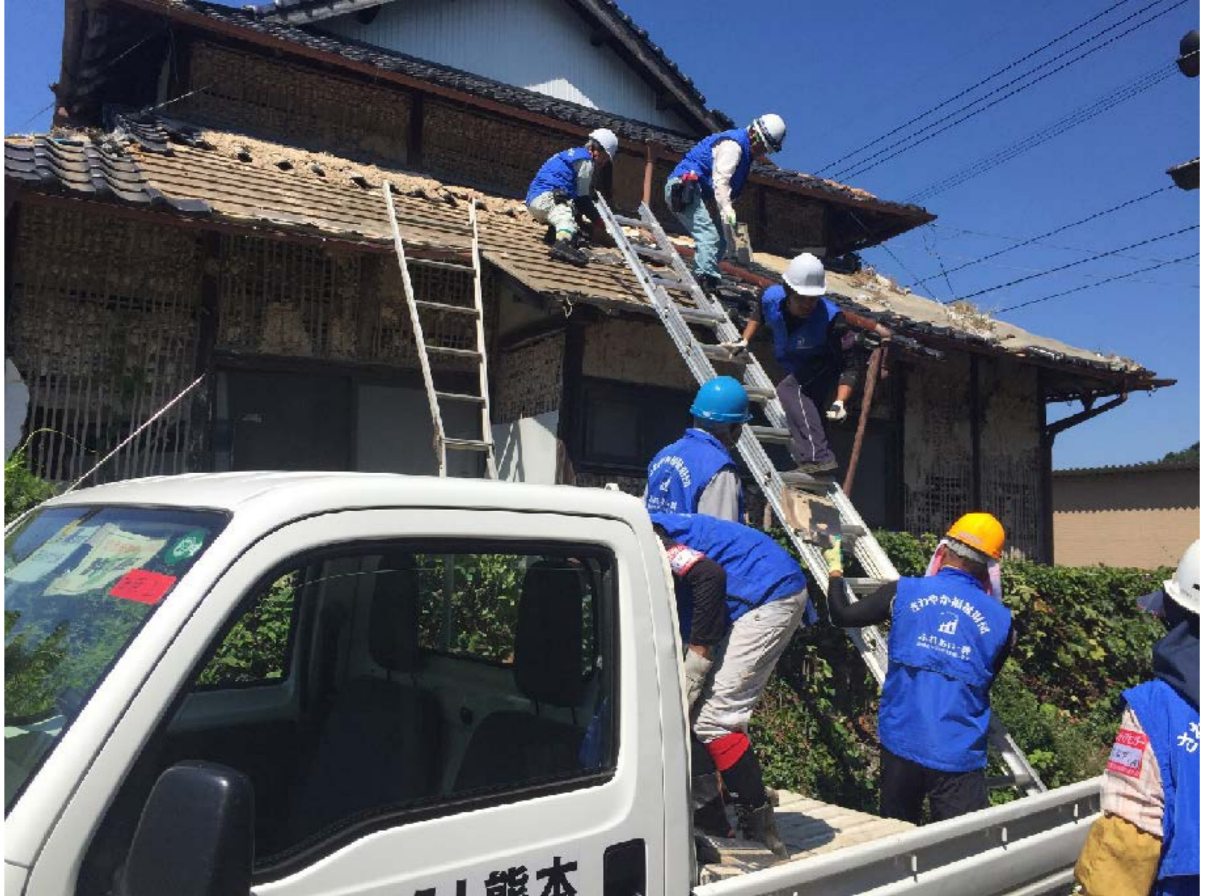
地震後の瓦撤去、ブルーシートはり
