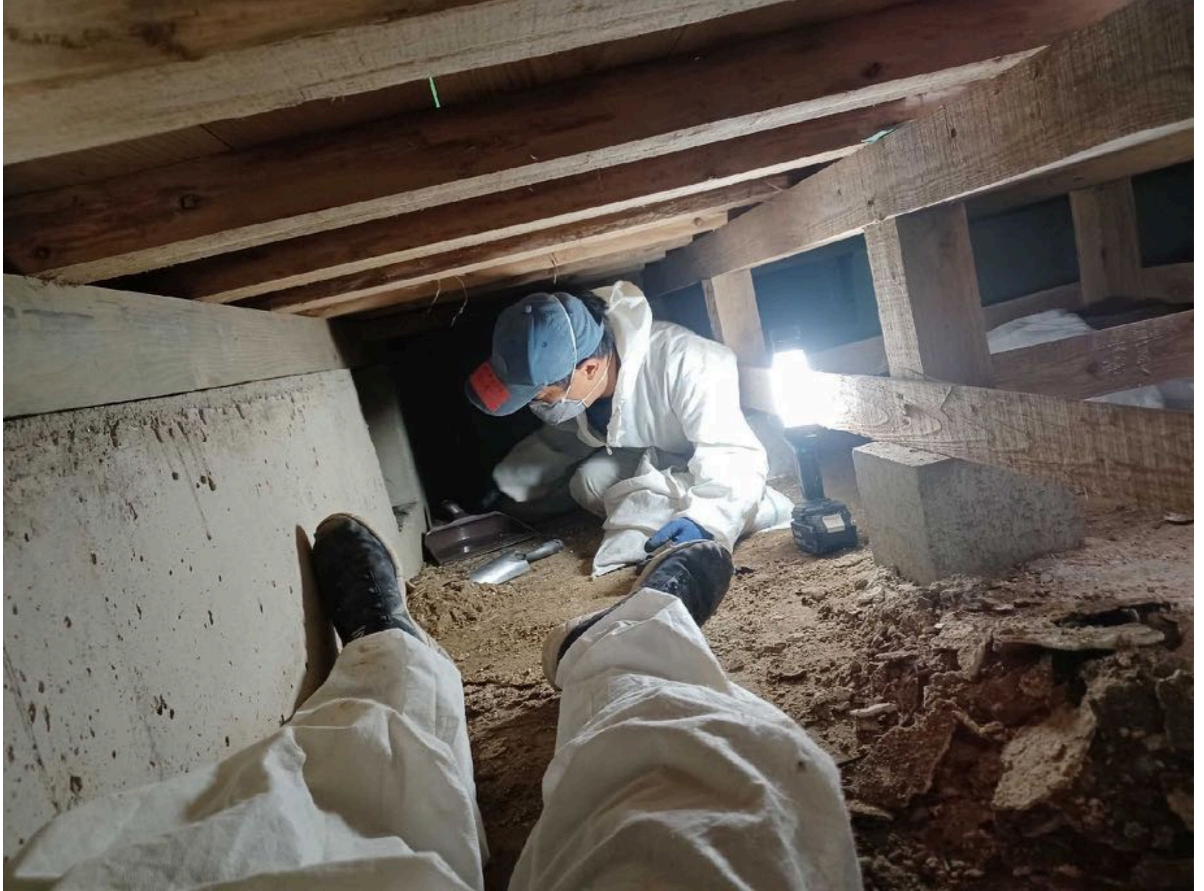
床下の土砂撤去
