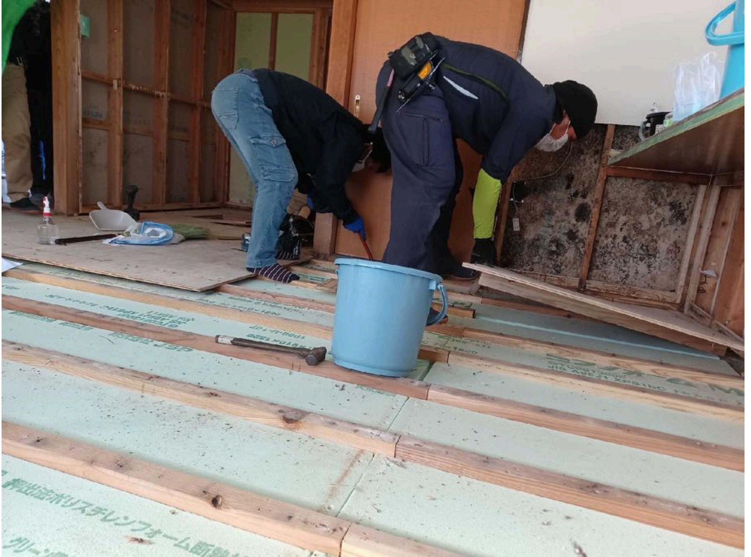
水害後の家屋の処理（床はがし／壁はがし）
