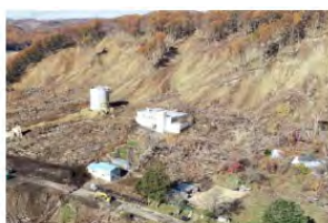
浄水場（富里地区）の被害状況
