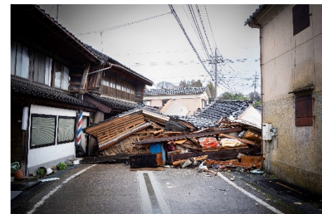
道路を塞ぐ倒壊家屋 重機系NPOが道路啓開
