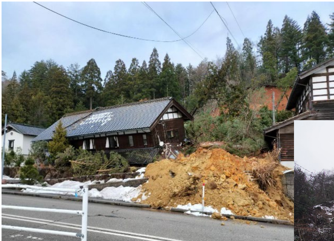
裏山土砂崩れによる家屋倒壊
