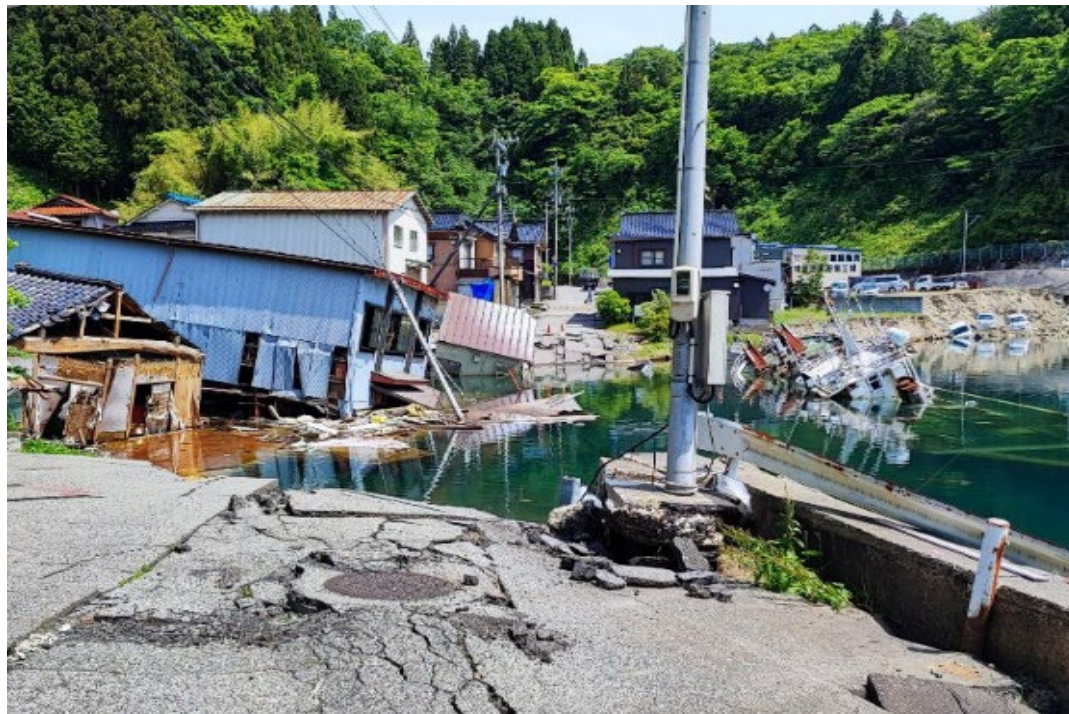
海沿いの道路崩壊
