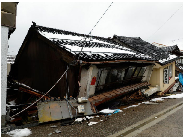
倒壊した店舗兼住宅
