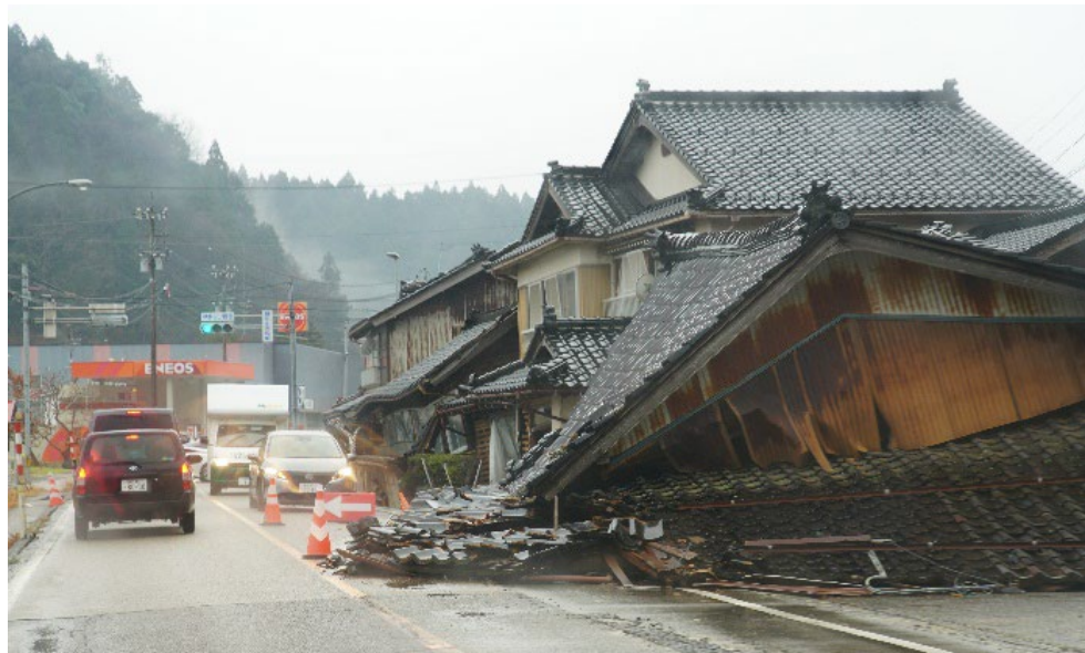
国道249号沿いの倒壊家屋
