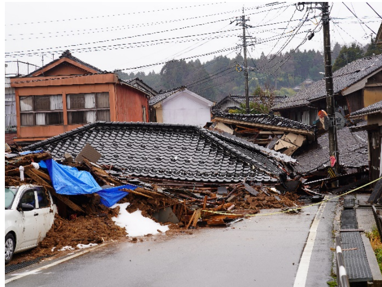
十字路に面する4棟のうち3棟が倒壊
