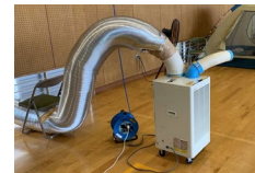
スポットクーラーの設置
