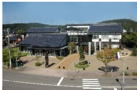
穴水町さわやか交流館プルート外観 (穴水町 HP より)
