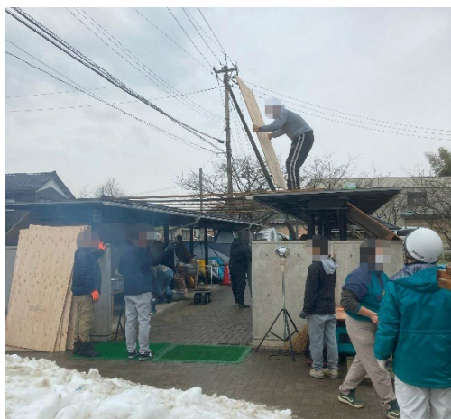
駐輪場を改造した炊き出し場の設置
