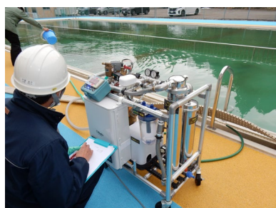
生活用水浄化装置によるプール水の浄化の様子(提供:クリタック株式会社)
