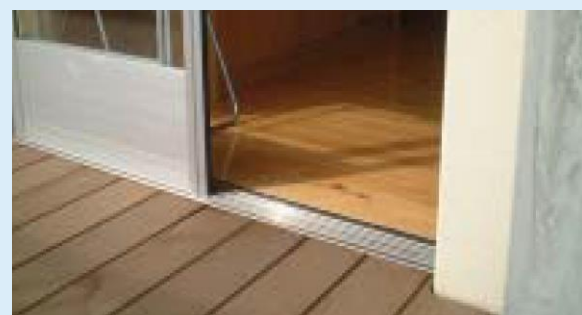
①教室とバル コニーの間 の段差を解 消した
