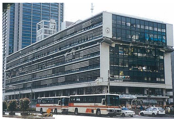
図 1-6 阪神・淡路大震災における神戸市役所の庁舎被害
