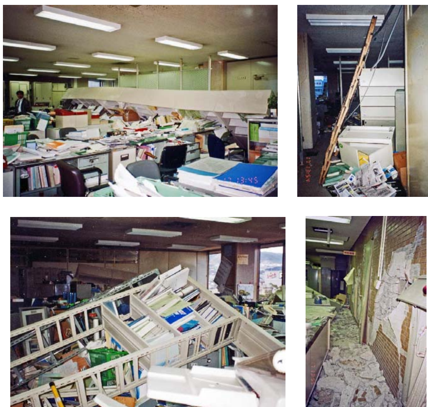
図 1-9 阪神・淡路大震災における西宮市役所の執務室及び廊下の状況
