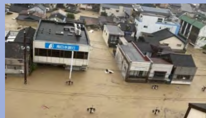
熊本県人吉市街部における 浸水状況
