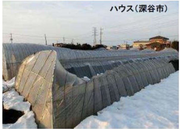
ビニールハウスの被害
