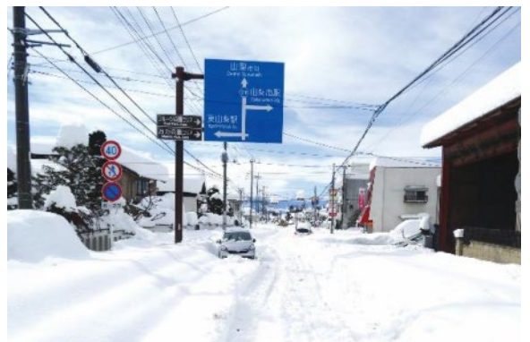
積雪により通行不能となった道路
