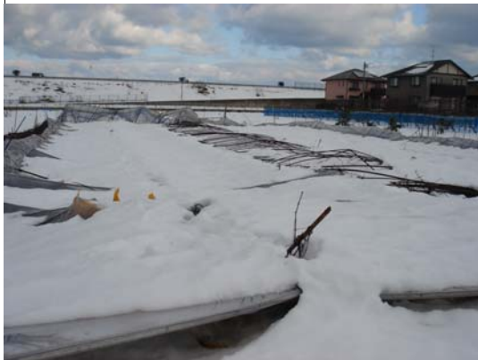
壊れたビニールハウスの様子
