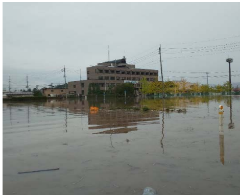
宮城県丸森町 被災状況
