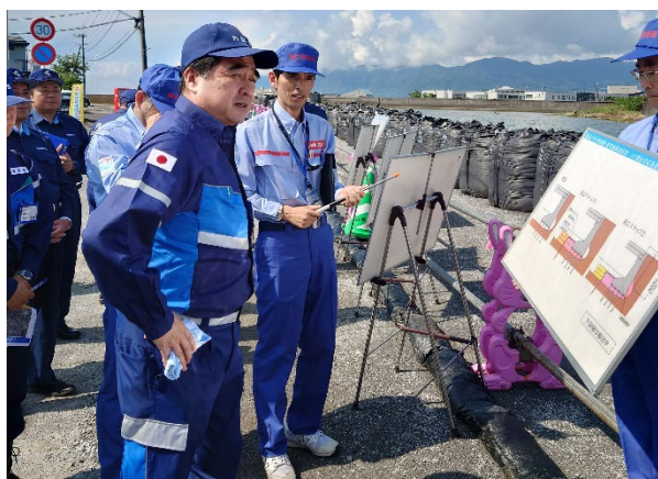
網掛川護岸崩落現場視察 【鹿児島県始良市】
