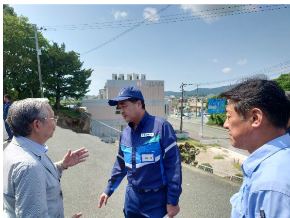
保育施設被災現場視察・ぶら下がり 【熊本県玉名市】
