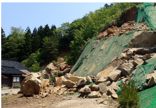
土砂崩落現場視察 【珠洲市正院町岡田】
