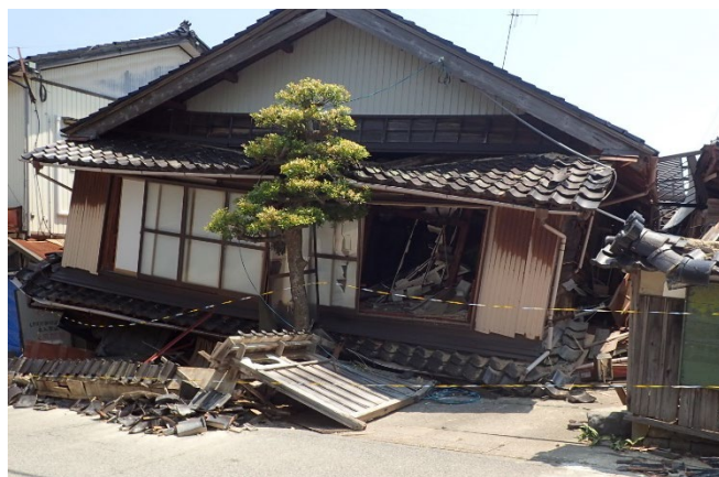
家屋倒壊現場視察 【珠洲市正院町正院】
