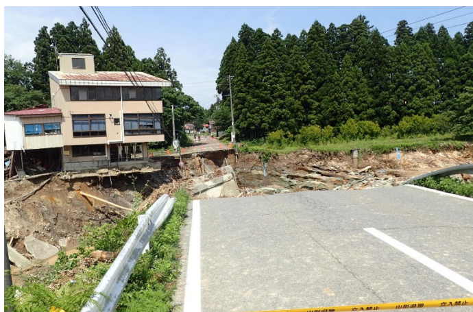
被災現場視察 【飯豊町】
