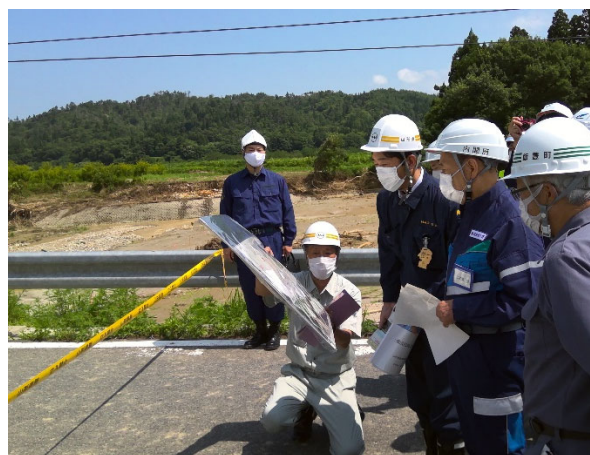
被災現場視察 【飯豊町】
