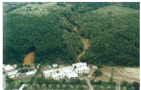
「太陽の国・からまつ荘」の被災状況 （福島県災害の記録）
