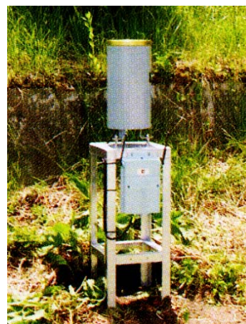
雨量計（湊支所） （岡谷市豪雨災害の記録）
