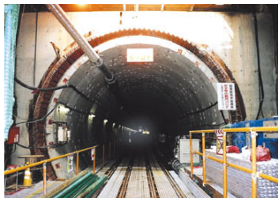
雨水管の工事状況（福岡市提供資料）
