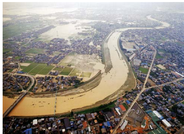
五十嵐川破堤場所（三条市豪雨災害の記録）
