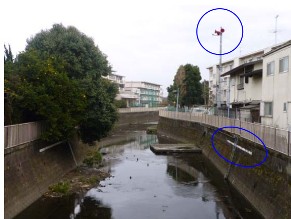
同報無線と警戒水位ライン
