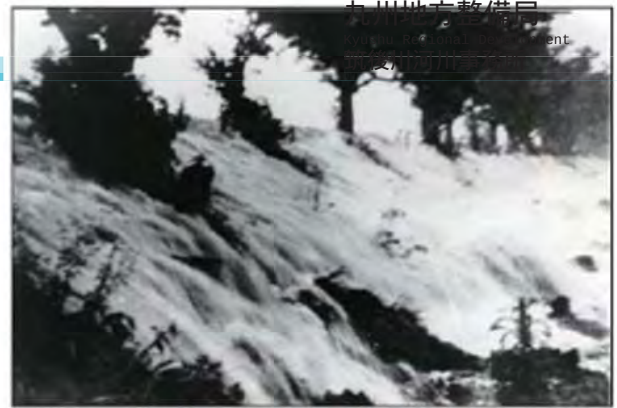
堤防からの越流（久留米市）
