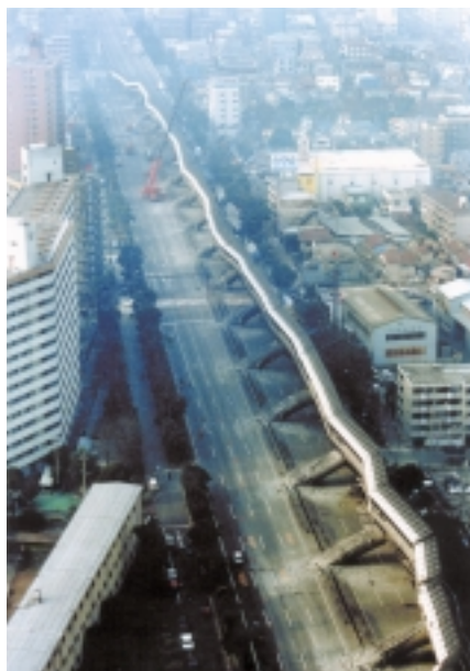
高速道路の崩壊(平成7年1月) Collapsed highway (Jan. '95)
