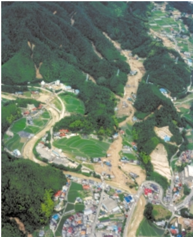
広島県豪雨災害 The Hiroshima Prefecture Torrential Rains Disaster 写真提供：広島県 Photo : Hiroshima Prefecture
