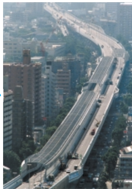
復旧した高速道路(平成8年9月) Restored highway (Sep. '96)
