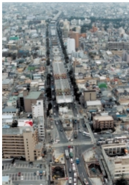
高速道路の復旧工事 Restoration work on the highway
