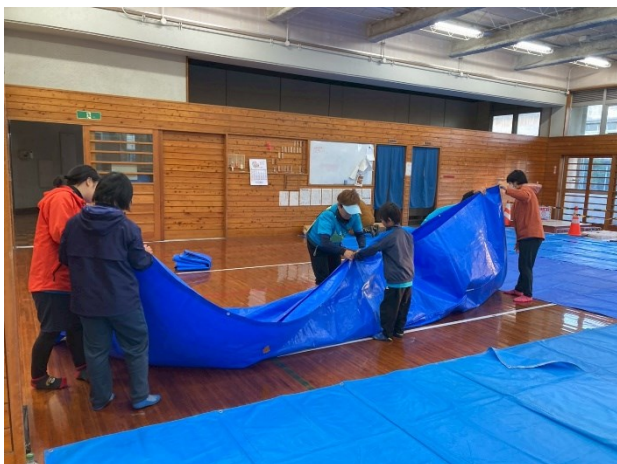
準備作業：床保護ブルーシート張り
