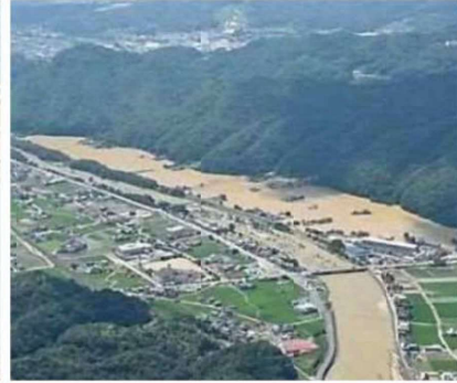
河川氾濫による浸水状況(三原市本郷町)
