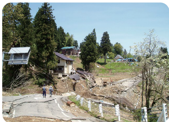
土砂の流入と道路の亀裂により寸断された農道
