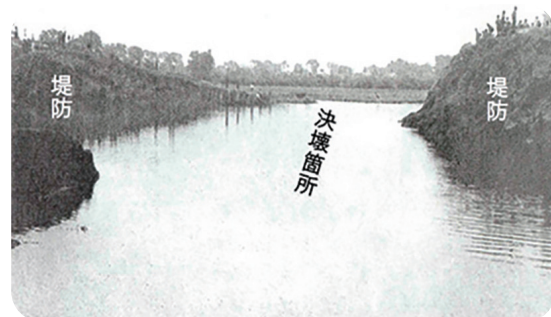
堤防決壊地点の様子（熊谷市久下地先）（出典：国土交通省関東地方整備局）
