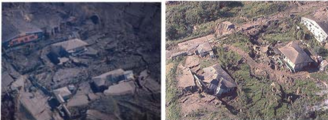
写真 建物の被害状況(提供：陸上自衛隊)
