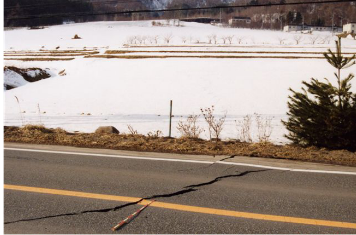
写真 壮瞥地区で3月30日に発生した地割れ(提供：北海道立地質研究所)
