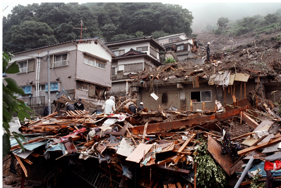
鳴滝町の土砂崩れ現場 提供：DEITz(株)（本書 23 頁）
