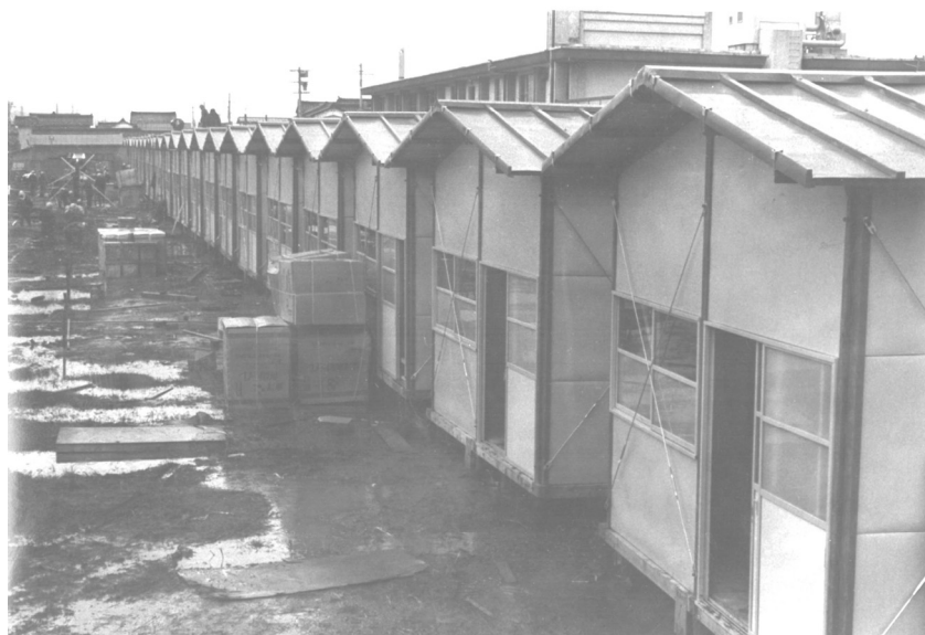
写真 4 - 10 応急仮設住宅の設置（酒田市提供）
