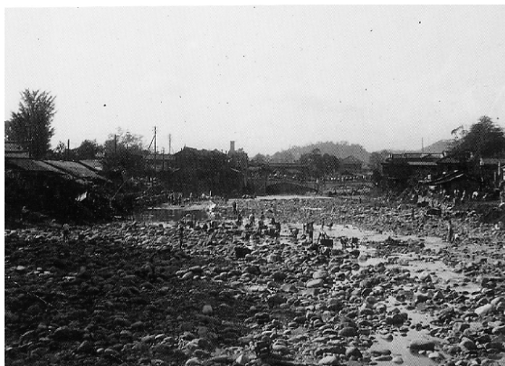
写真3-4 洪水後川幅を大きく広げた新川（渡良瀬川工事事務所, 1999）
