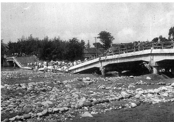
写真3-11 桐生川にかかる旧50号線境野橋の被害 (境野町) (渡良瀬川工事事務所, 1999)
