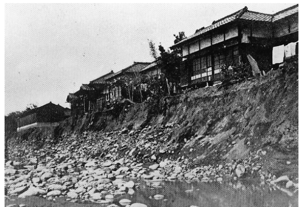
写真3-2 流失寸前で難を逃れた新川橋上左岸沿いの住宅（巴町）（渡良瀬川工事事務所, 1999）
