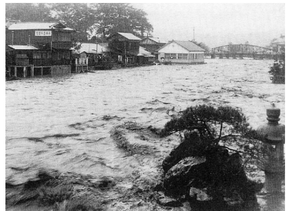
写真3-3 桐生市内の氾濫状況（渡良瀬川工事事務所, 1999）
