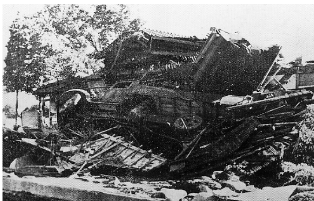
写真3-9 氾濫流により2階より高く 押し上げられたトラック (渡良瀬川工事事務所, 1999)
