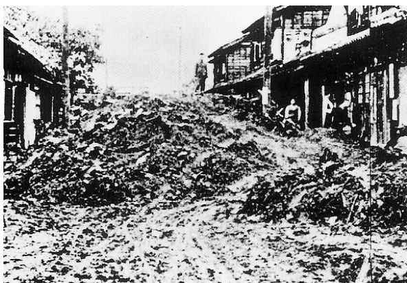
写真3-6 中通りに氾濫堆積した土砂 (浜松町2丁目) (渡良瀬川工事事務所, 1999)
