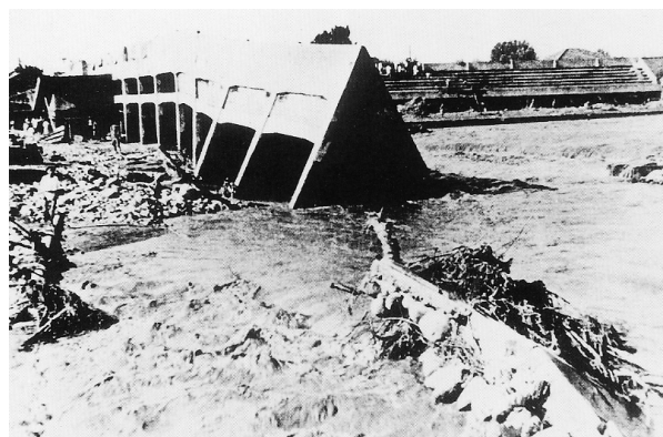
写真3-1 倒壊した新川グラウンド (新川筋・稲荷町)
