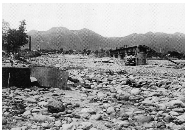
写真3-10 両毛線桐生川鉄橋の流失 (境野町) (渡良瀬川工事事務所, 1999)
